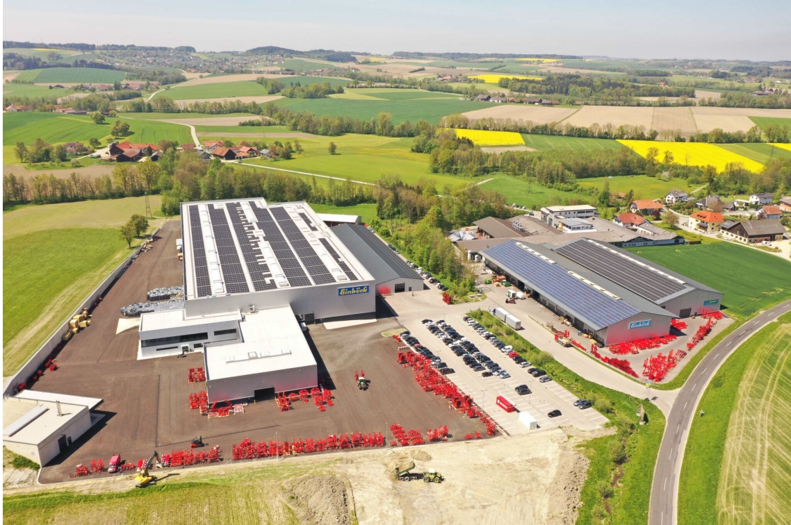
In die Erweiterung des neuen Werkes wurden insgesamt 35 Millionen Euro investiert. (Foto: Werkbild)
