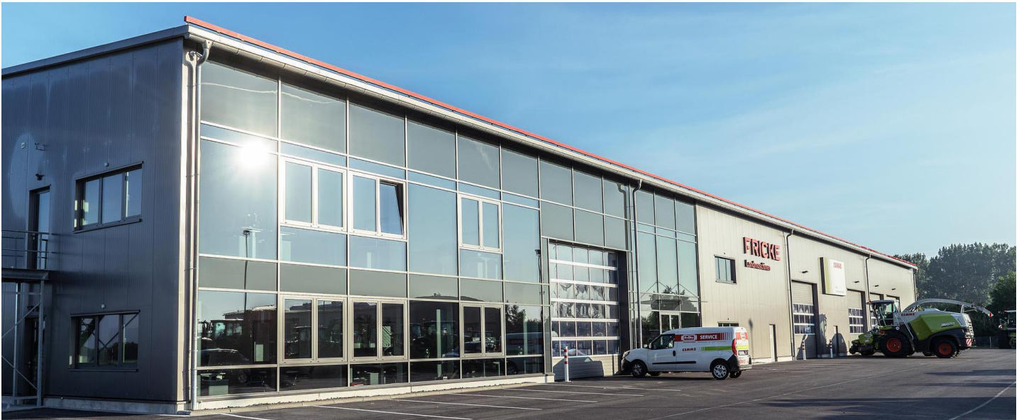
Das neue Hauptgebäude der Fricke Landmaschinen in Heeslingen beinhaltet Büros, einen Shop, Ersatzteillager und die Werkstatt.. FOTO: FRICKE
